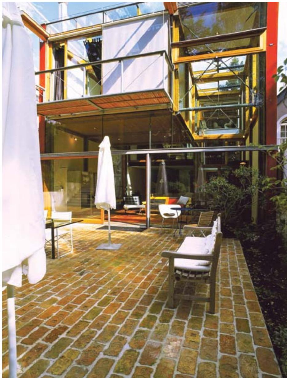
原先的老房子被一个钢结构牢牢地固定着，并且原建筑的南外墙被整体外移。从外墙延展出一块8立方米的垂直立方体。之所以建造这个具有巨大玻璃构件的立方体，是因为它不但大大开阔了从旧建筑部分到花园之间的视野，而且也很好地解决了缺乏光线的问题。
